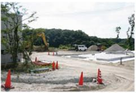
プログラム準備棟 建築工事
