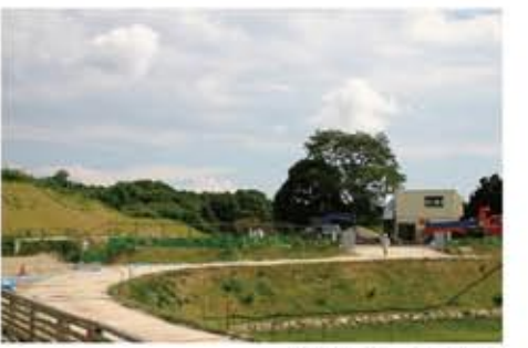
あいな亭 建築工事
