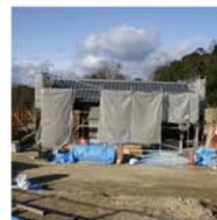
トイレ棟工事
