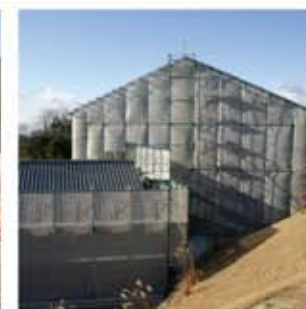
あいな亭・食堂棟工事
