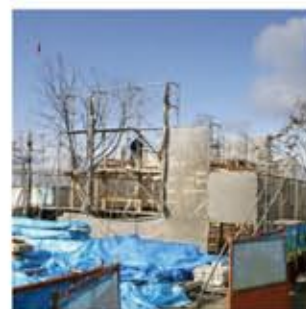
総合案内所工事
