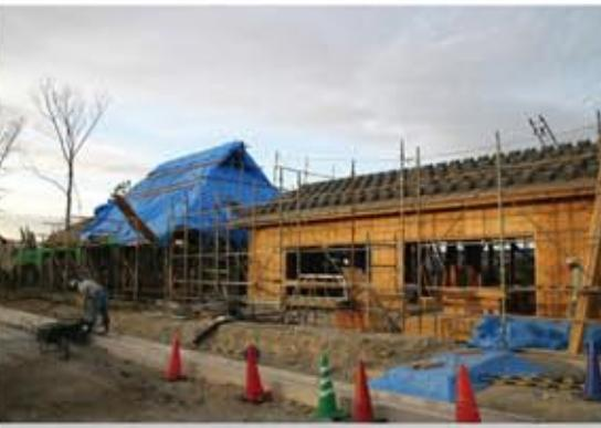
クラブハウス本棟と、倉庫2棟の計3棟を建築しておりますが、先に倉庫棟が形になっておりました。倉庫のうち、1棟は茅葺き屋根で、既に屋根工事に取り掛かっています。面積の広い本棟は、現在基礎が創られている段階です。
