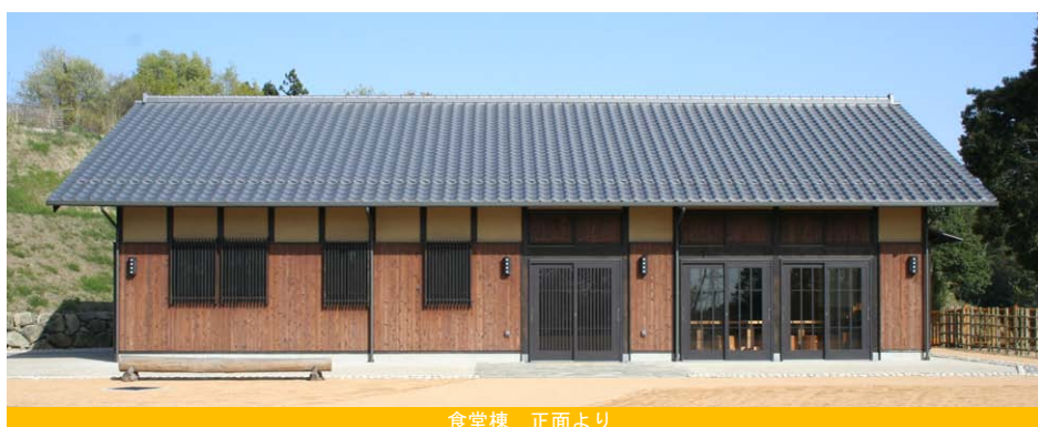
食堂棟 正面より
